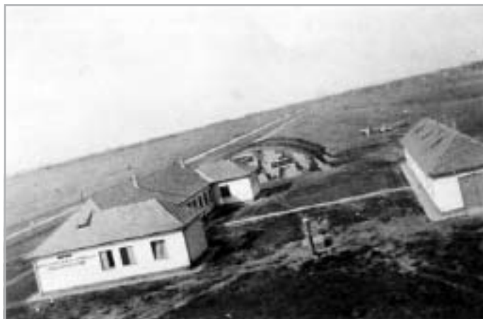
7. ÁBRA A SZENTESIEK EGYIK BÜSZKESÉGE, A PÍLÓTAOTTHON, BENNE HÁLÓKKAL, FÜRDŐVEL, MŰHELLYEL, GONDNOKI LAKÁSSAL, STB. A SZÁLLÁSHELYEN PING-PONG, SAKK, RÁDIÓ ÉS TÁRSASJÁTÉKOK TALÁLHATÓ. AZ ALAKULÓTÉR MÁSIK OLDALÁN AZ IRODA, A VENDÉGSZOBA, A 10-12 MÉTER HOSSZÚ GARÁZS, RAKTÁR, MŰHELY, AHOL A LEGNAGYOBB JAVÍTÁST IS EL LEHET VÉGEZNI. ANYAGHIÁNY MIAT KÖZEL HÁROM ÉVIG TARTOTT AZ ÉPÍTKEZÉS, ÍGY CSAK 1943 AUGUSZTUSÁRA KÉSZÜLHETETT EL. (GULLAY-ARCHIVUM)
