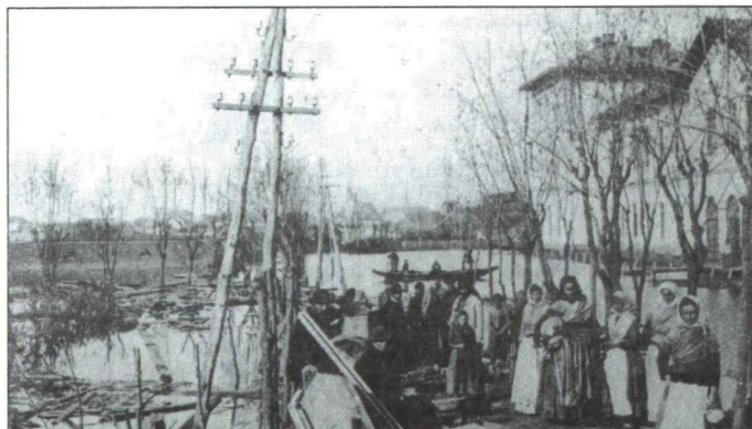
8. ÁBRA AZ INDÓHÁZ TÉR A LEVONULÓ ÁRVÍZ IDEJÉN
