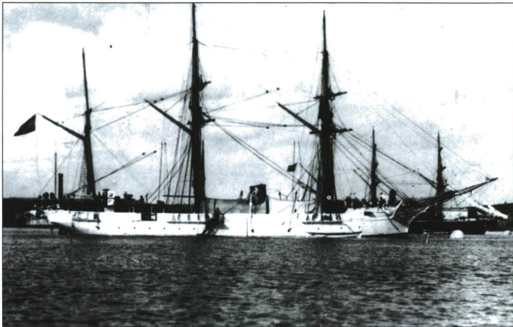
A VITORLÁVAL ÉS GŐZGÉPPEL EGYRÁNT FELSZERELT CSAVAROS ÁGYÚNASZÁD JELLEGZETES PÉLDÁJA AZ ALBATROSZ. 1872-74 KÖZÖTT ÉPÜLT PÓLÁBAN. TÖBBSZÖR JÁRT MISSZIÓ ÚTON KELET-ÁZSIÁBAN, DÉL-AMERIKÁBAN, AFRIKÁBAN ÉS AUSZTRÁLIÁBAN. 1902-BEN ISKOLAHAJÓ. A VILÁGHÁBORÚBAN LAKÓHAJÓ VOLT. OLASZORSZÁGNAK ÍTÉLTÉK, AHOL LŐSZERTÁROLÓ HAJÓKÉNT SZOLGÁLT
