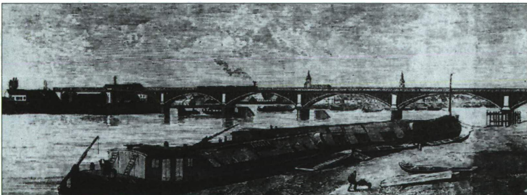
Szegeden 1858-ban a világ első pneumatikus alapozású hidját építették a Tisza fölé, M. Cézanne francia mérnök tervei alapján. Ez a kép néhány évvel az átadás után készült. Érdekes, hogy a híd kétvágányú volt, annak ellenére, hogy kétvágányú fővonal azóta sem épült erre felé.
