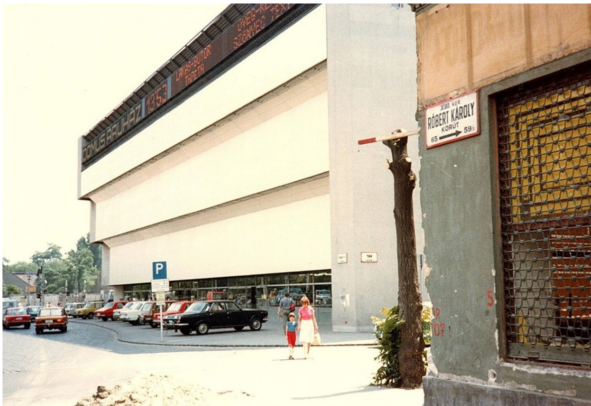
A Domus Áruház és a szanálás alatt lévő Tar utca 10.
