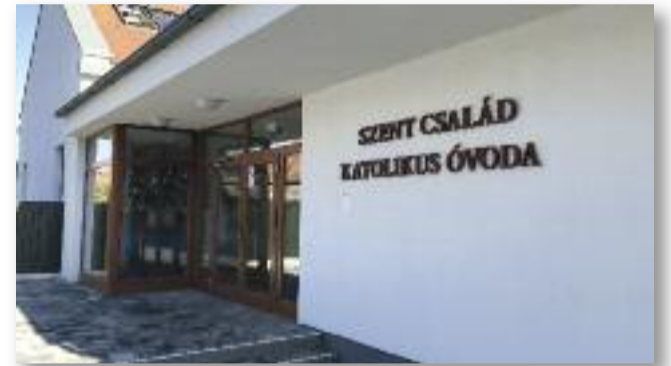
Az egykori Zárda-kápolna megújult épülete
