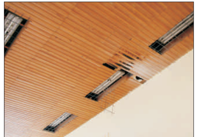
Az előregedett lámpatest tüzet okozott a tornateremben
