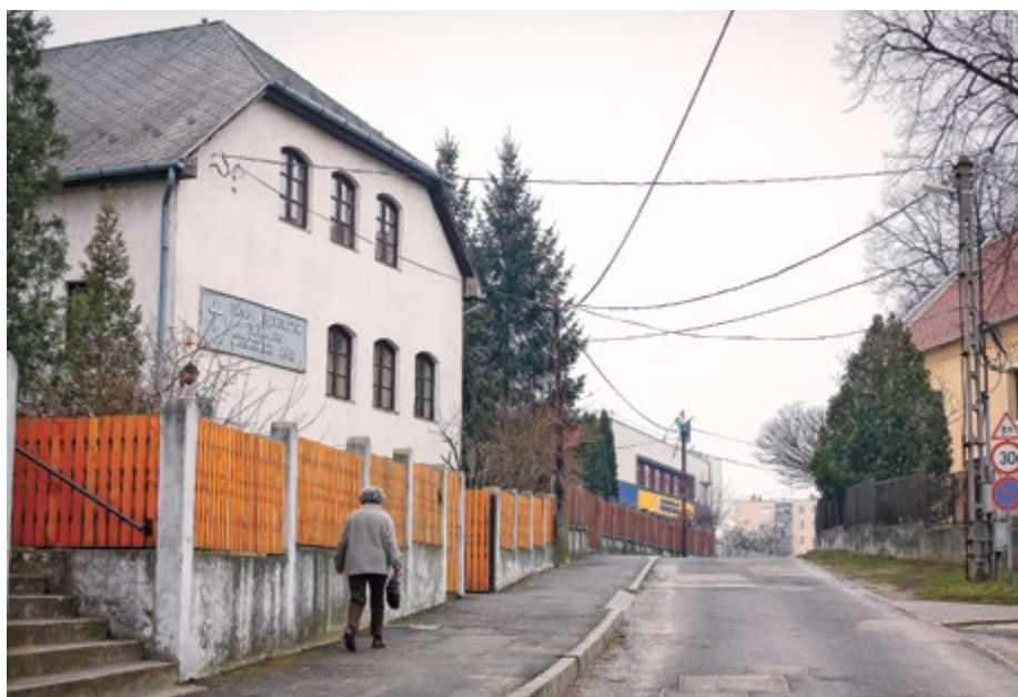
RENDEZŐDIK A CSAPADÉKVÍZ-ELVEZETÉS A DÓZSA GYÖRGY ÚTON
