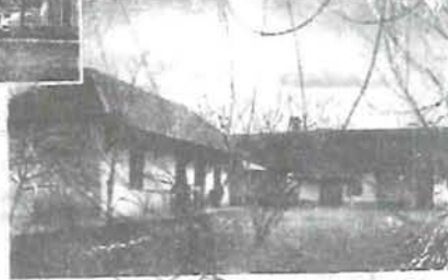
Endrődi róm. kath. Egyházközség munkaház.
