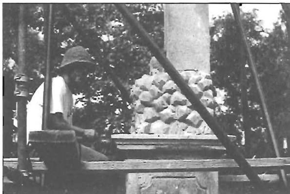
Munkában a restaurátorok. Folyik a templom előtti kereszt felújítása.
