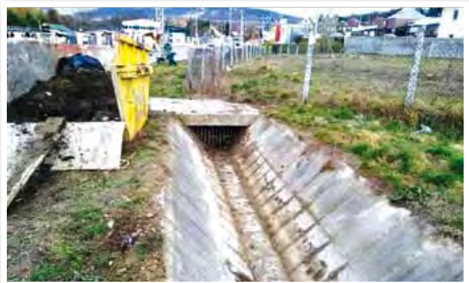
Völgyligeti csapadék elvezető árok tisztítása
