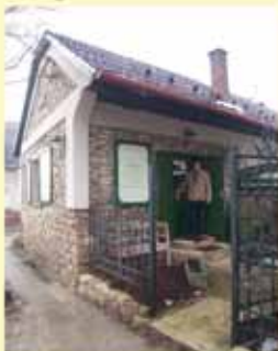
Pilisborosjenő Templom út 2.
