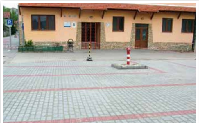
Óvoda előtti parkoló és tűzcsap építése
