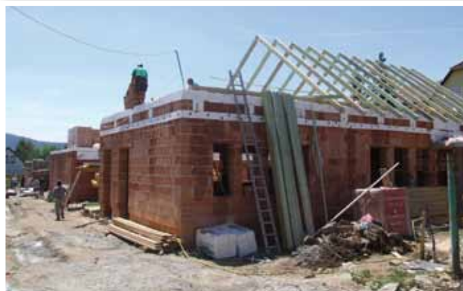
Megkezdődött a bölcsőde építése
