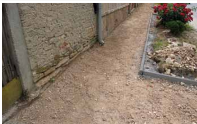
Fő utcai járda építése
