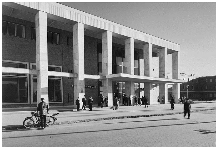
MÁV állomás („Nagyállomás”)
