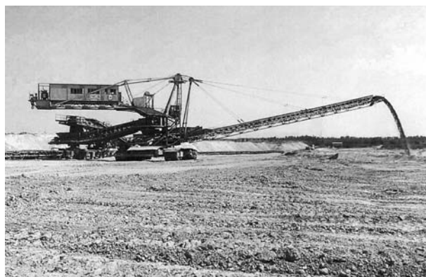
4. ábra: Hányóképző gép (HK 5)
