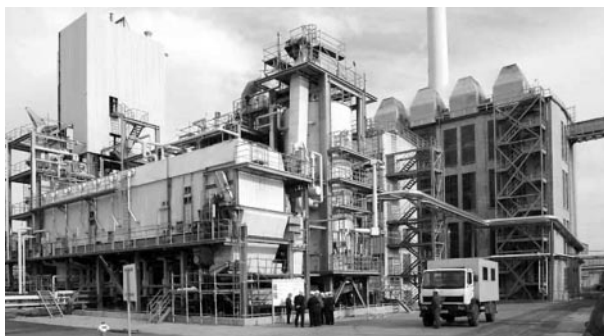
6. ábra: A Freiberg (leállított) szénelgázosító üzem Németországban [5]
