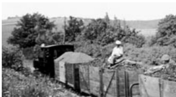
12. ábra: Szén szállítás gőzmozdonnyal Mohorácsra
