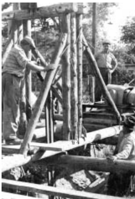
3. kép: Szádoló állványszerkezet
