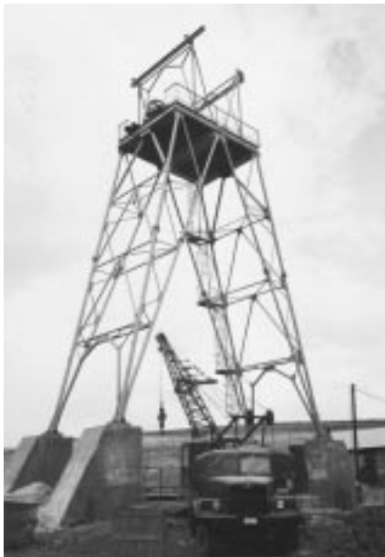
7. kép: Duplex csőtorny szerelés közben Nagyegyházán
