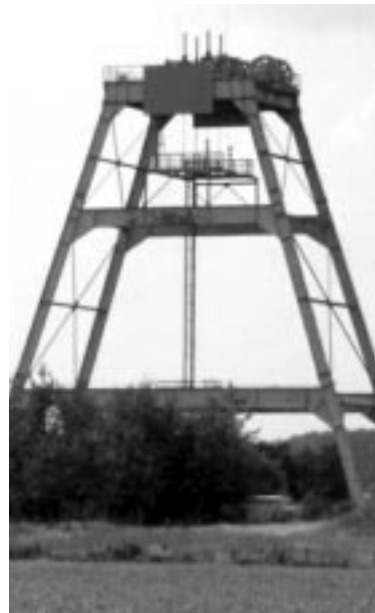
8. kép: Nagy terpesztésű kettős korongpadozatú mélyítő torony
