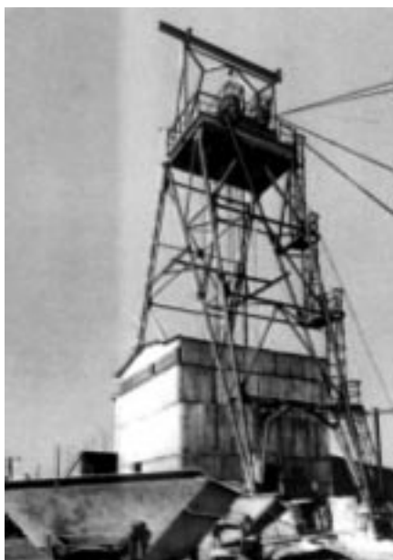
6. kép: Szimplex csőtorny Halimba II. szállítóakna mélyítésénél
