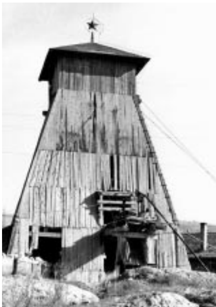
4. kép: Normál aknamélyítő fenyőfa torony. Sárísáp. XIX. akna
