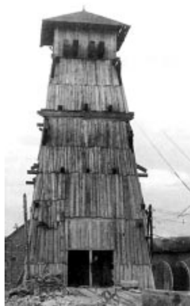
5. kép: Magasított, kettős korongpadozatú fenyőfa torony
