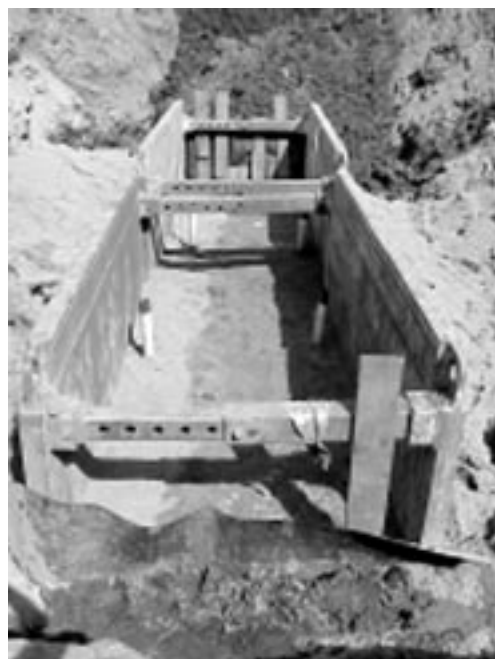
8. ábra: A gát építése a megfigyelő kutak elhelyezésével. Látható a két különböző vastartalmú réteg
