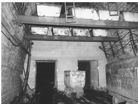
3. kép: Falazott gát gyorszáró ajtókkal
