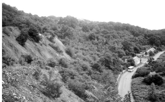
2. ábra Vasas Bánya, üzemudvari meddőhányó tájrendezés előtt
