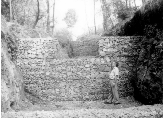
8. ábra Övárók helyreállítása az István I-II aknai meddőhányón
