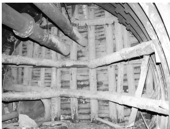
2. kép: Iszapgát beépített légcatornával
