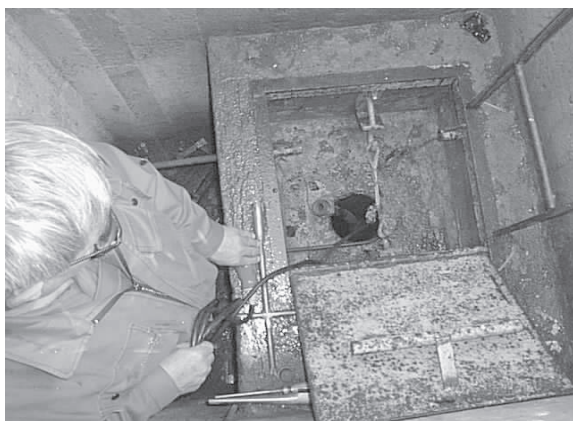
2. kép Vízszintmegfigyelő kút feje belülről
