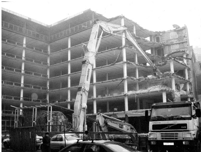
Irodaépület bontása harapófogóval és bontókalapáccsal Budapesten, 2003. februárjában.
