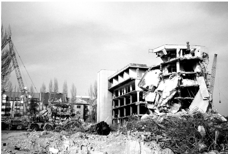
A MOM-gyár 28. sz. épületének bontása golyózással 1998-ban
