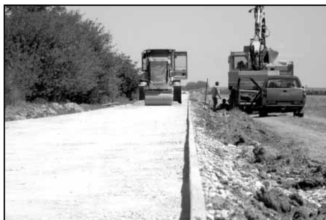
...máshol az útalap elkészítésével foglalkoznak a gépek
