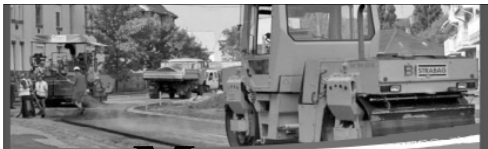
Városunkban a Széchenyi utcán épül ki az első olyan szilárdburkolatú út, amely teljes hosszában szilárdított szegéllyel kerül kialakításra
