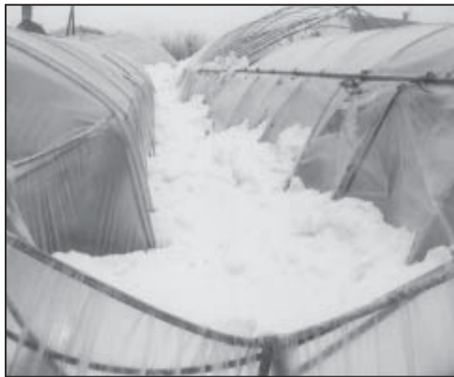
Egy a hó súlya alatt összeroppant sarkadi fólia
