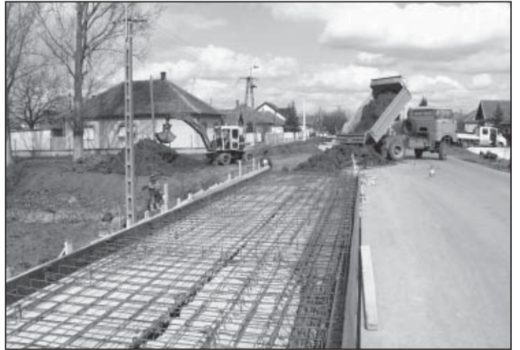
Az Ady Endre utcánál a Kopolya-csatorna hídjának átalakítása
