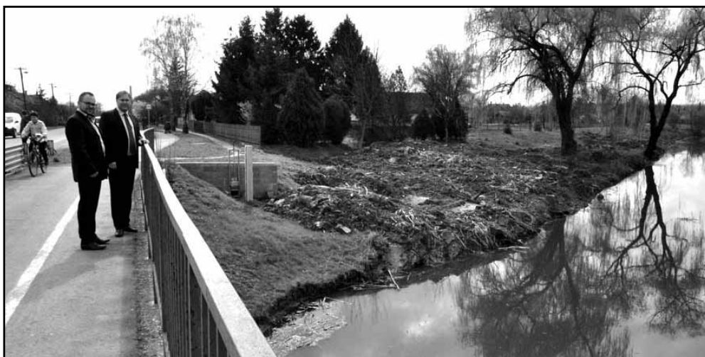
A Bárkás csatorna Anti úti híjánál a már elkészült szakasz
