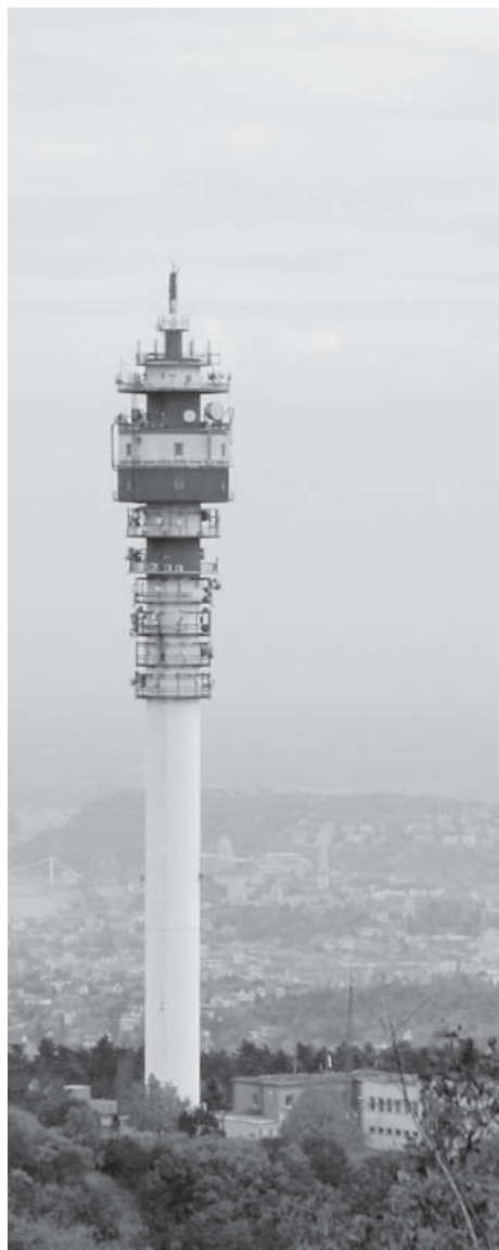
Az egykori zavaró-adó területén, az egymást érő antennák helyén ma a BRFK 92 m magas beton-acél tornya és két, kétszintes, lapostetős épület áll.
