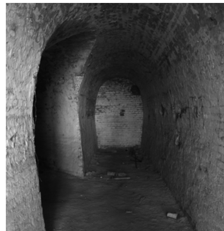
Téglalobtozatú táró bejárati szakasza
