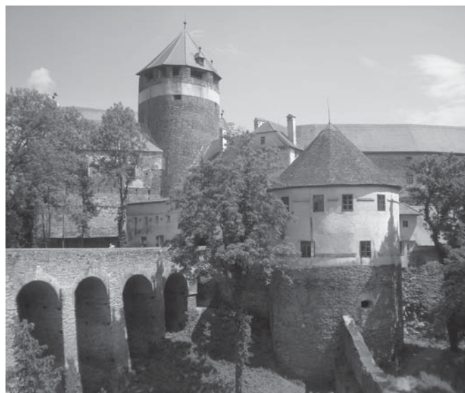
A külsőtornyos Szalónak vára a középkor óta szinte teljes épségben fennmaradt. Kapuját 12 pilléren nyugvó hídon lehet megközelíteni.
