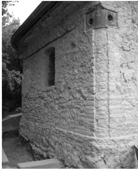
A letisztított falazaton jól látszik a lábázat és saroklázéna egykori helye.
