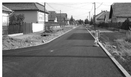
A Gábor Áron utcában már az útpadkát készítik, a Gyóni Géza utcában a vízvezeték árkolás folyik. Útépítés, dolgozik a depónia
