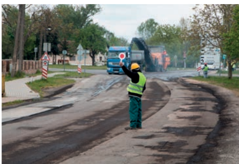
Elkezdődött az útfelújítás. (Április)
