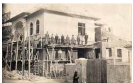
Az épülő posta
