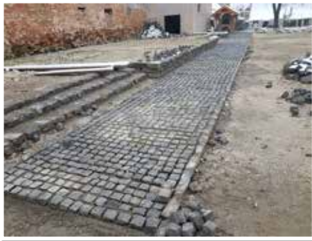
Folyik a munka a Belvárosi Piac- és Rendezvénytéren. A térköves brigád tagjai készítik a macskaköburkolatot.
