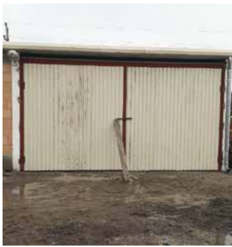
Elkészült az új csarnok kapuja. A munkát Molnár András Kadocsa vezetésével a Városüzemeltetési Kft. munkatársai végezték.
