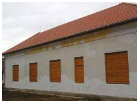
24. Homlokzatjavítás a melléképületeken az egykori Barta kórház területén
