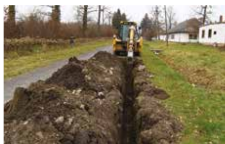
26. Meggyeserdőn több mint 300 m nyomvonalon a Kft. kicserélte a vízvezetékét
