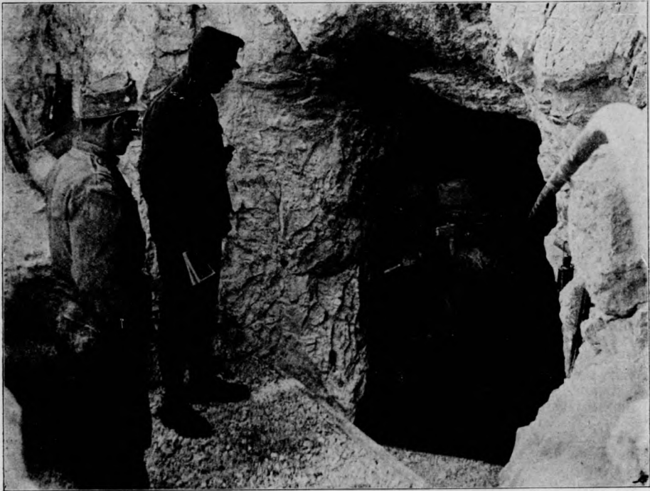
Böhren eines Stollens zur Unterbringung von Mannschaft und Geschützen im Felskampsgebiet.
