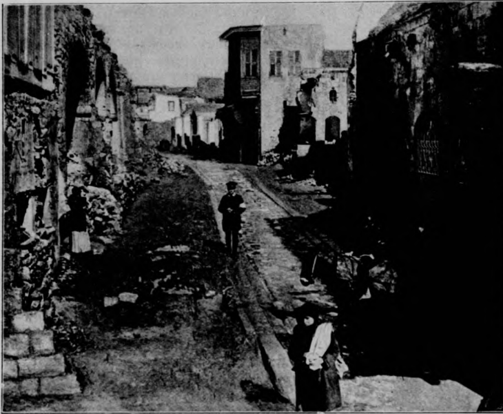
Zerstörte Straße in Aleppo.
