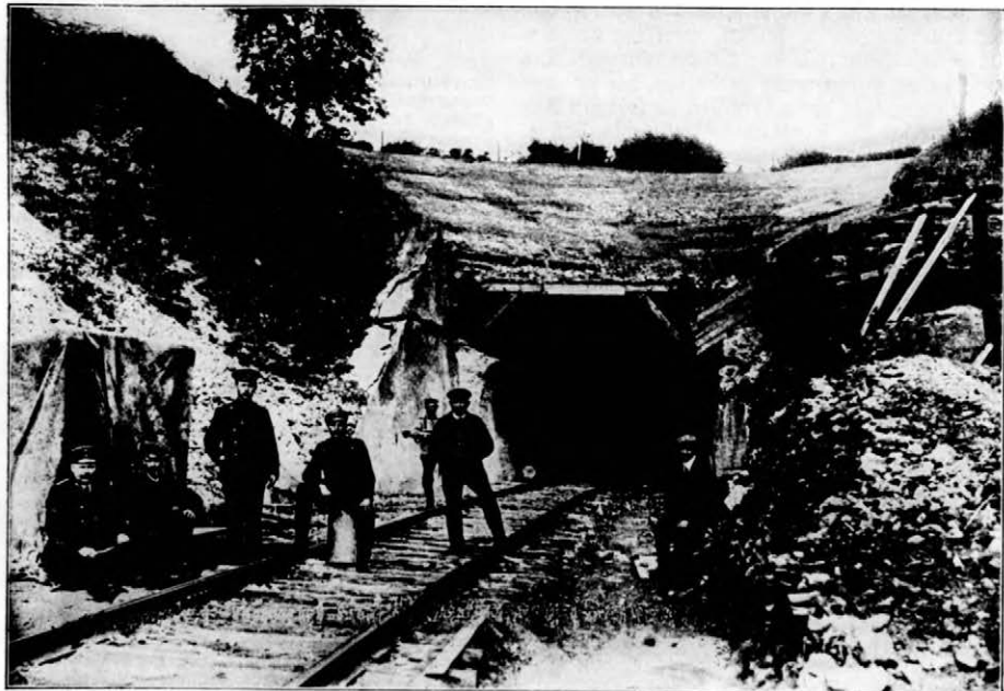
Ein belgischer Eisenbahntunnel, der zur Behinderung der deutschen Bahntransporte von den Belgiern zerstört und von den Deutschen binnen kurzer Zeit wiederhergestellt wurde.
