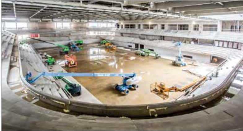
Már félkész állapotban is megmutatja igazi katlanjellegét az épülő Alba Aréna
