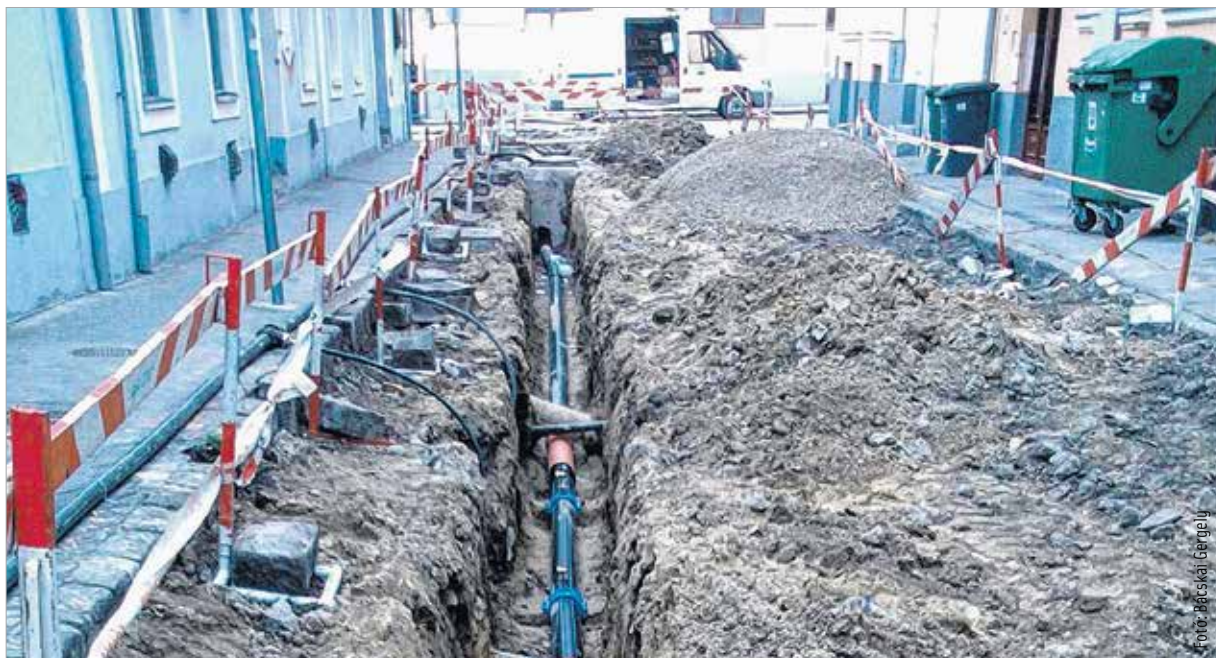
A következő időszakban több hasonló csapadékvíz-elvezetést érintő beruházás lesz a városban
