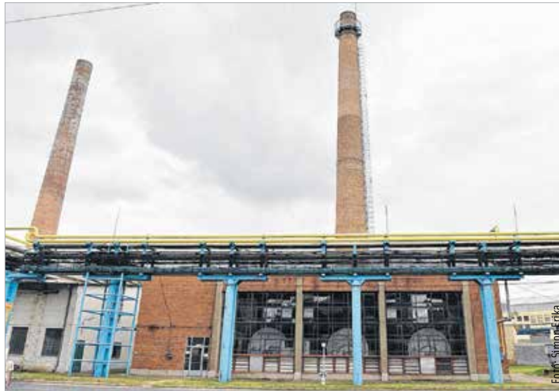
A fehérvári fűtőerőmű régi berendezései, épületei immár a történelem részévé váltak
