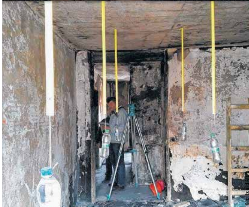
Három tonnányi súlyt raktak a megrogyant födémre, de a panel bírta a terhelést
