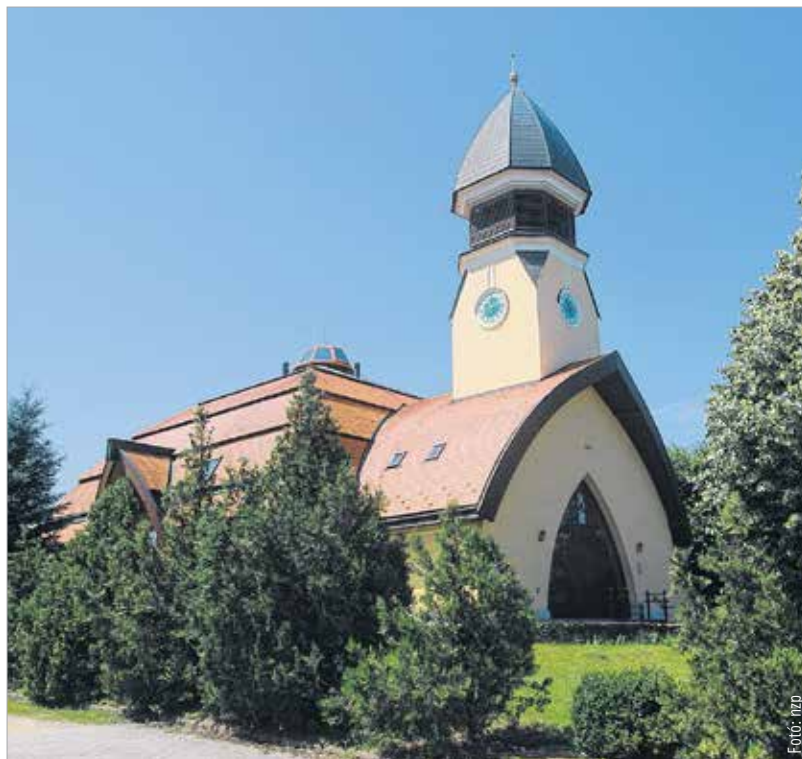
A nívódíjjal kitüntetett építmény tetőszerkezete a modern technikák alkalmazása mellett is esztétikai értékkel bír, és a belső térben kellemes akusztikát biztosít
