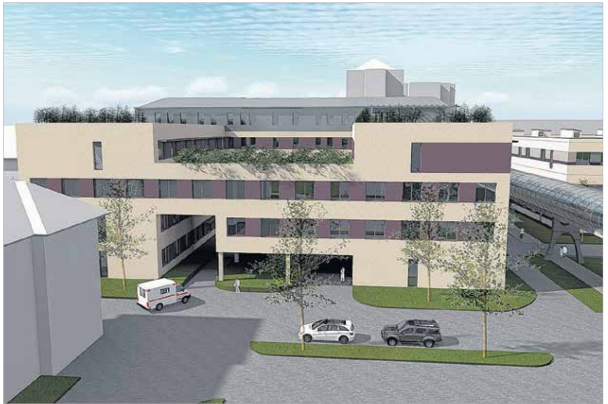
Az idei évben indul el az új, ötszintes belgyógyászati tömb építése, ami a már kialakított infrastruktúrára csatlakozik
