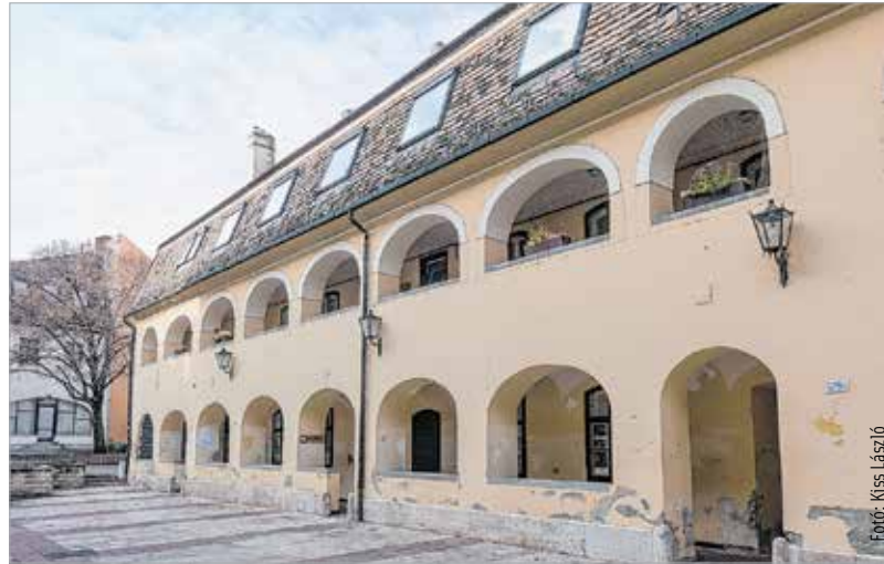
Győry László (1807–1882) Székesfehérváron kezdte a közéleti pályáját. A Pelikán udvar árka-dós házrésze volt a lakóépülete.
