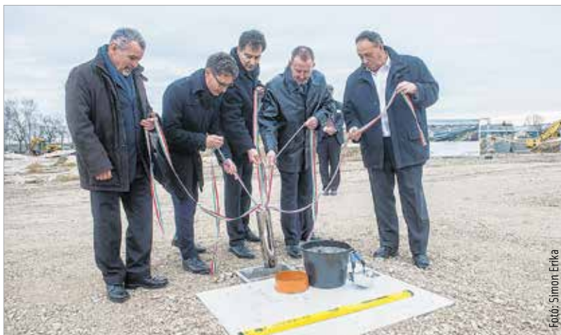
Az építkezés elkezdődött, letették az alapkövét az új gyártócsarnoknak
