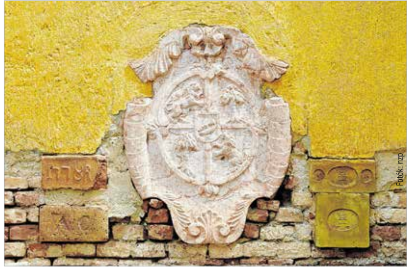
A pálosok címere, mely a 13. században épült, azóta többször átalakított, felújított vértessacsai templom oldal falán található
