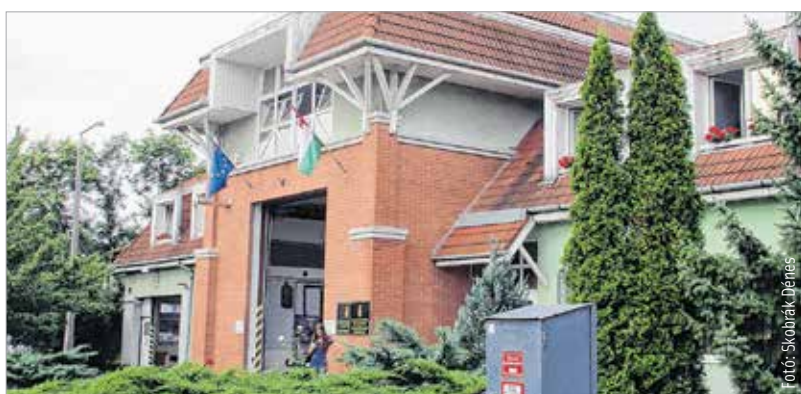
A Sárkeresztúri úton lévő Közlekedési Osztály és Útgyűri Osztály épületén az összes ablakot kicserélték, korszerű külső hőszigetelést is kapott. Több napelem is beépítésre került.
