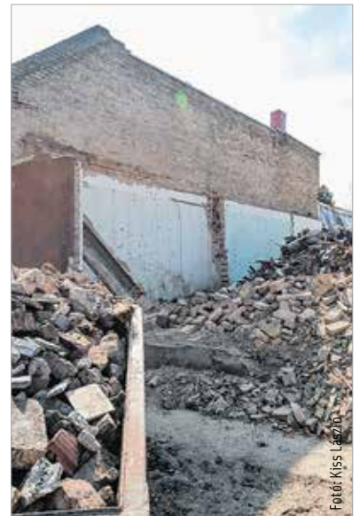
Gyakran találkozunk Fehérváron ezzel a képpel: a telken lévő régi házakat lebontják, helyükre új építésű társasházak kerülnek
