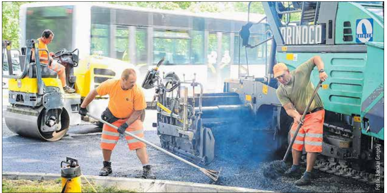
A kivitelezések ideje alatt a közlekedők megértését és türelmét kéri a szakemberek!
