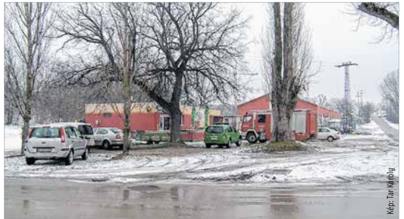
Az áldozat feltehetően az épületben töltötte az éjszakát
